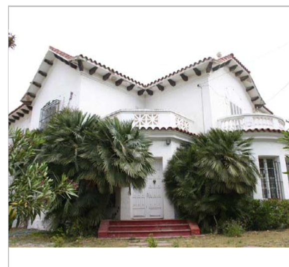
Vista de la casa. 3.5.2006. Diputació de Barcelona
