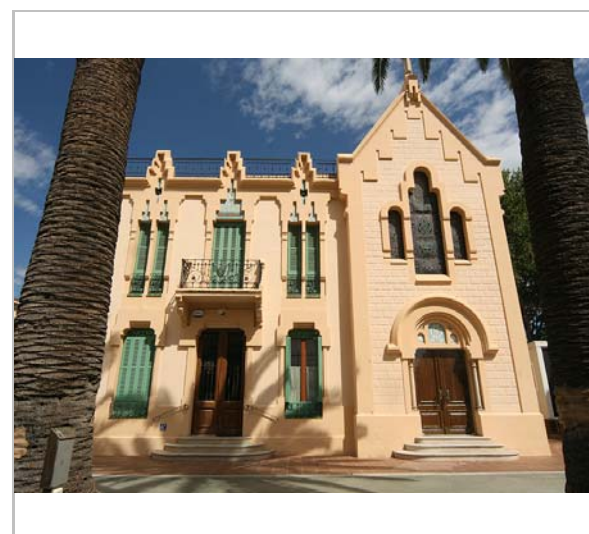
Vista de la casa. 13.8.2014. JM. Pujol
