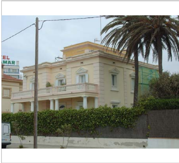
Vista de la casa. 2006. Diputació de Barcelona
