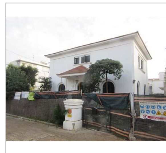
Vista de la casa. 5.12.2015. JM. Pujol
