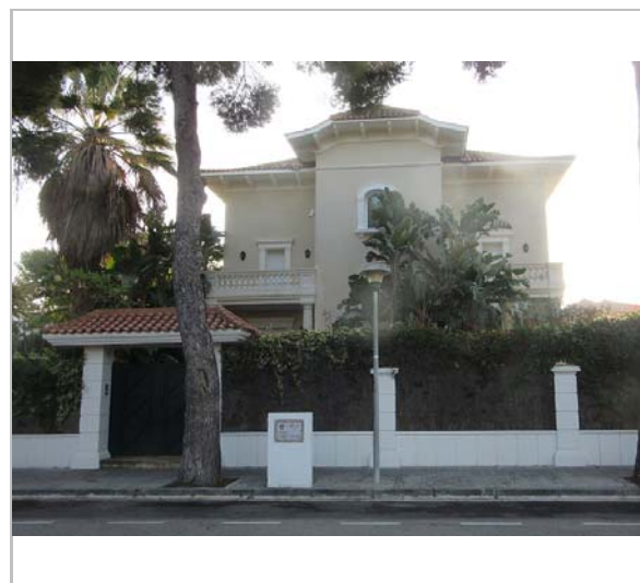
Vista de la casa. 9.12.2015. JM. Pujol
