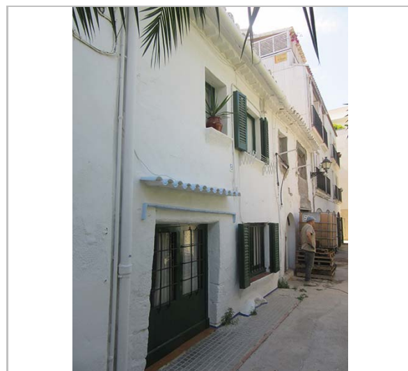
Façanes. 1.7.2016. Sixto Pujol
