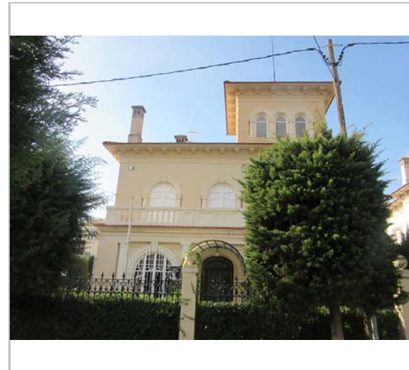
Vista de la casa. 11.12.2015. JM. Pujol
