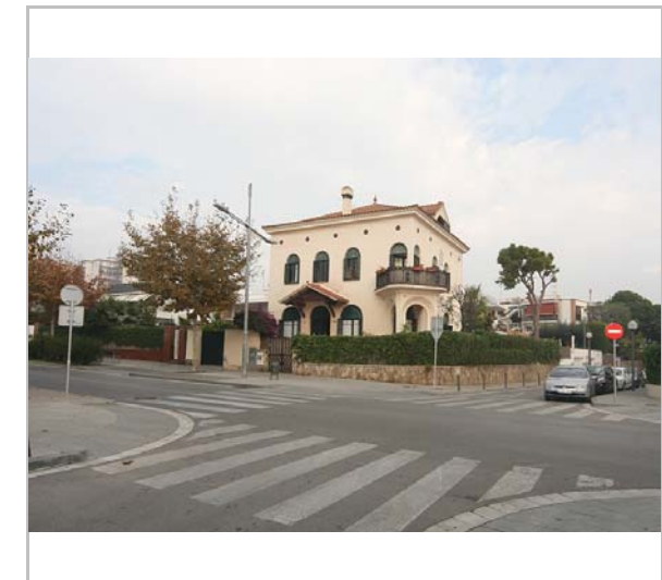
Vista de la casa. 5.12.2015. JM. Pujol
