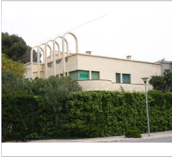
Vista de la casa. 2006. Diputació de Barcelona
