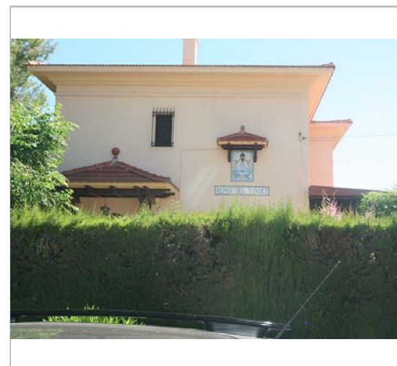
Façana lateral. 23.6.2016. Sixto Pujol
