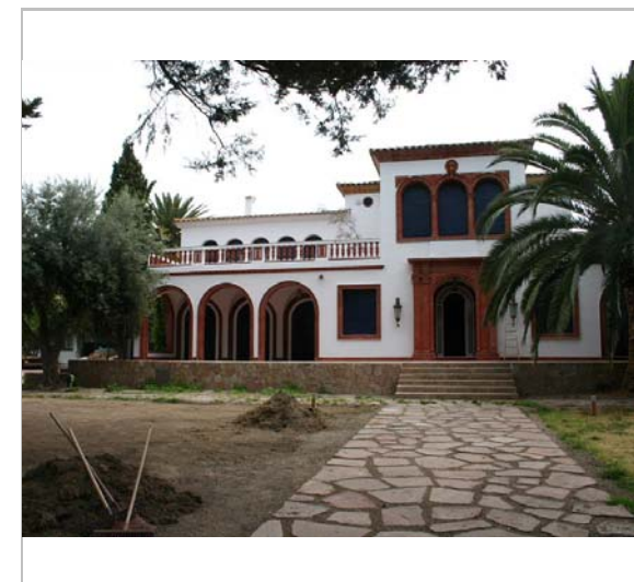
Vista de la casa. 2006. Diputació de Barcelona
