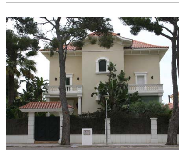
Vista de la casa. 2006. Diputació de Barcelona
