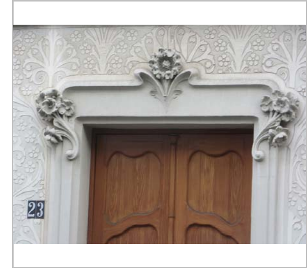
Detall de la façana. 9.12.2015. JM. Pujol
