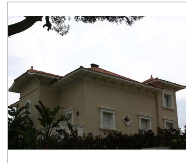
Vista de la casa. 2006. Diputació de Barcelona
