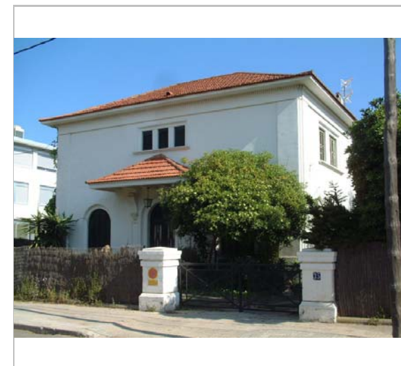
Vista de la casa. 2006. Diputació de Barcelona
