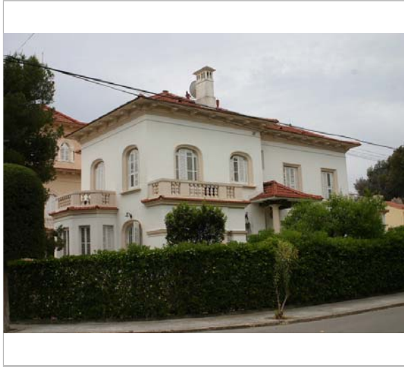
Façana principal. 2006. Diputació de Barcelona
