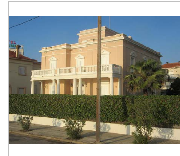
Vista de la casa. 9.12.2015. Diputació de Barcelona
