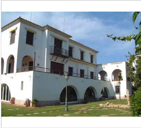
Vista de la casa. 2006. Diputació de Barcelona
