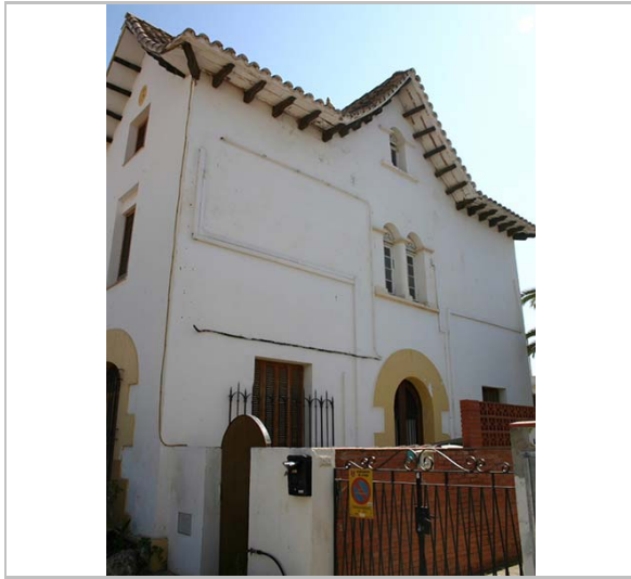
Vista de la casa. 2.5.2006. Diputació de Barcelona
