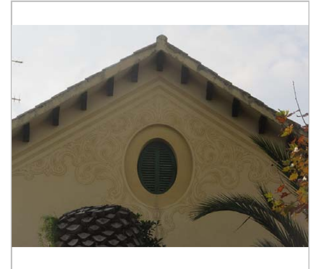
Detall de la façana. 5.12.2015. JM. Pujol
