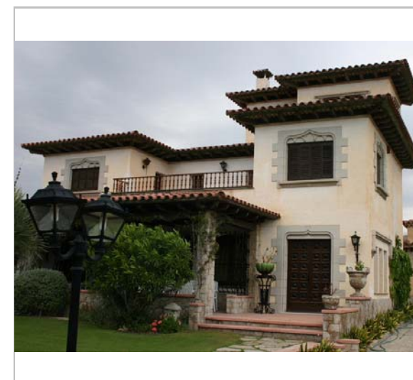
Vista de la casa. 2006. Diputació de Barcelona
