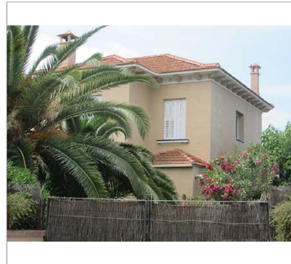
Vista de la casa. 3.7.2016. JM. Pujol
