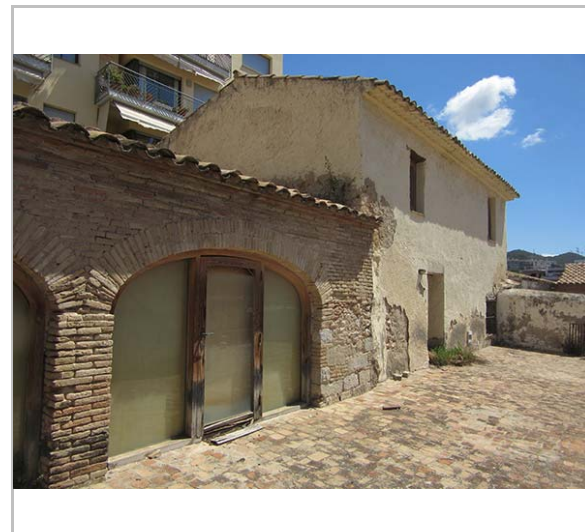
Façana de migdia. 2016 JM. Pujol
