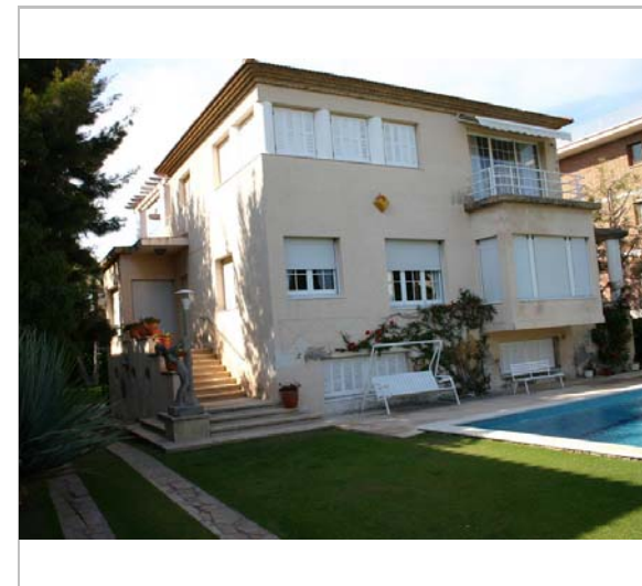
Vista de la casa. 2006. Diputació de Barcelona
