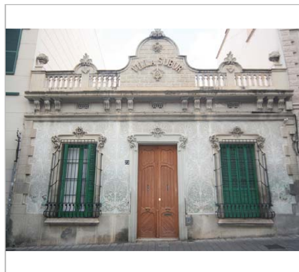
Façana. 9.12.2015. JM. Pujol
