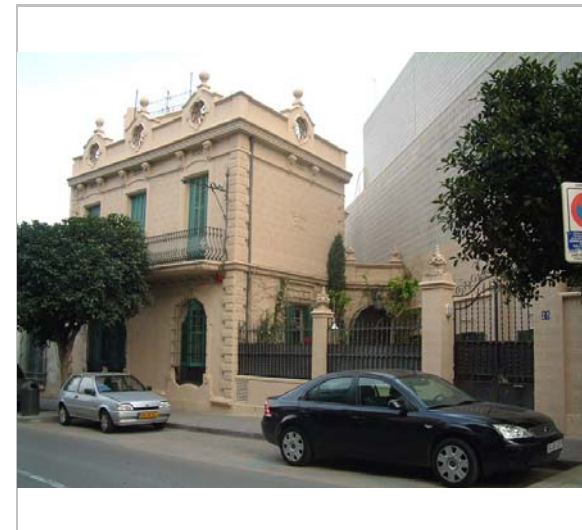
Vista de la casa. 2006. Diputació de Barcelona
