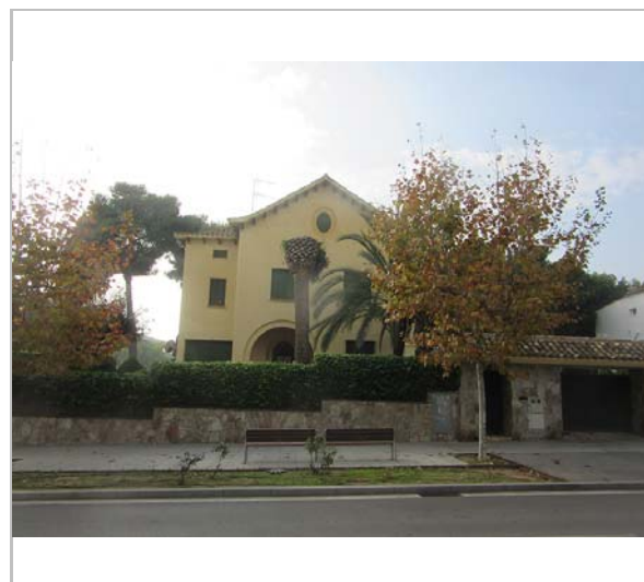
Vista de la casa. 5.12.2015. JM. Pujol
