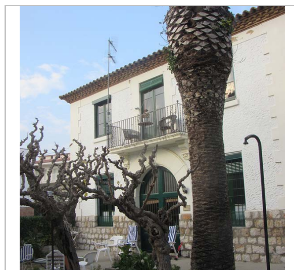
Vista de la casa. 2015. JM. Pujol
