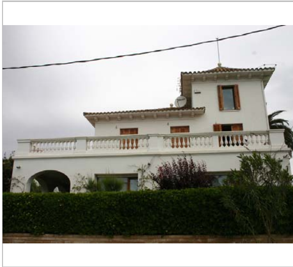
Vista de la casa. 3.5.2006. Diputació de Barcelona
