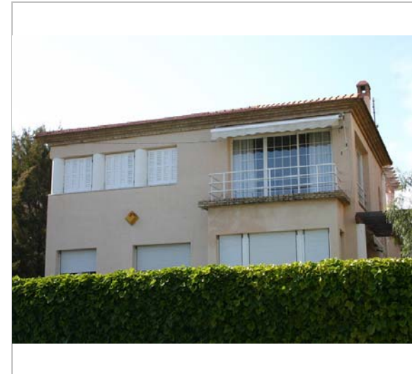
Vista de la casa. 2006. Diputació de Barcelona
