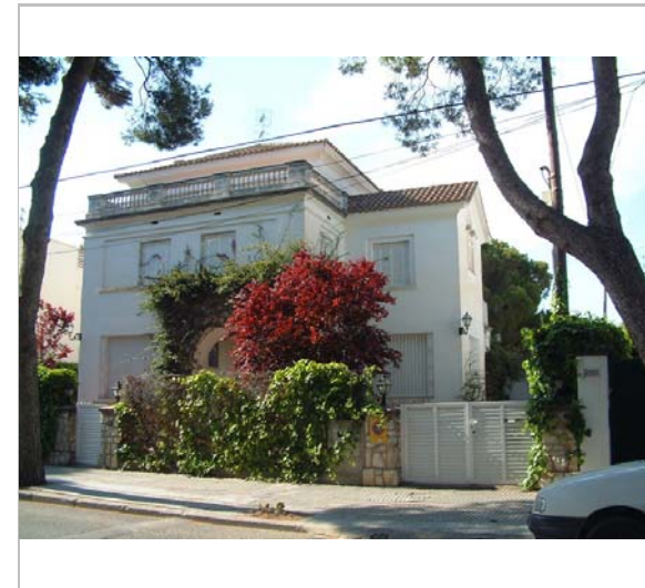
Vista de la casa. 2006. Diputació de Barcelona
