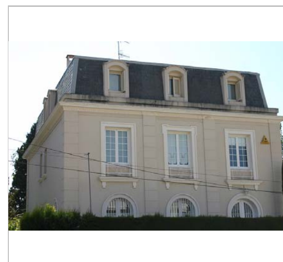
Vista de la casa. 2.5.2006. Diputació de Barcelona
