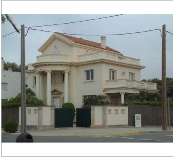
Vista de la casa. 2006. Diputació de Barcelona
