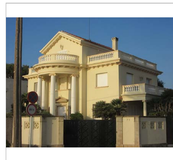
Vista de la casa. 9.12.2015. JM. Pujol
