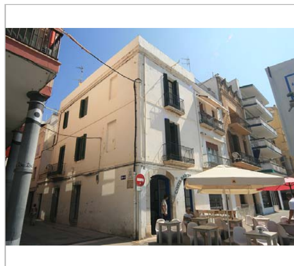
Vista de l'edifici. 27.6.2016. Sixto Pujol
