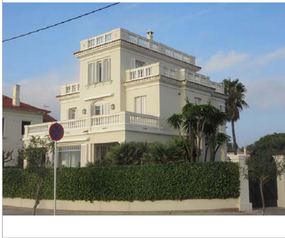
Vista de la casa. 9.12.2015. JM. Pujol
