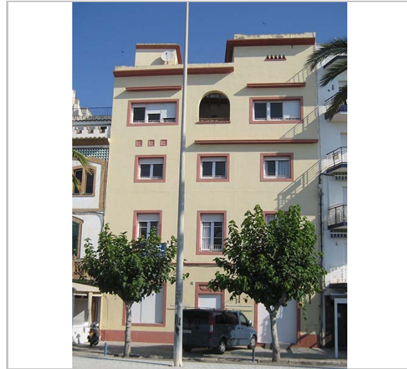
Façana. 12.7.2015 JM. Pujol
