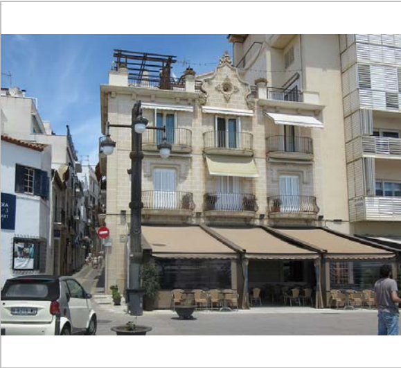
Façana. 9.6.2016. JM. Pujol
