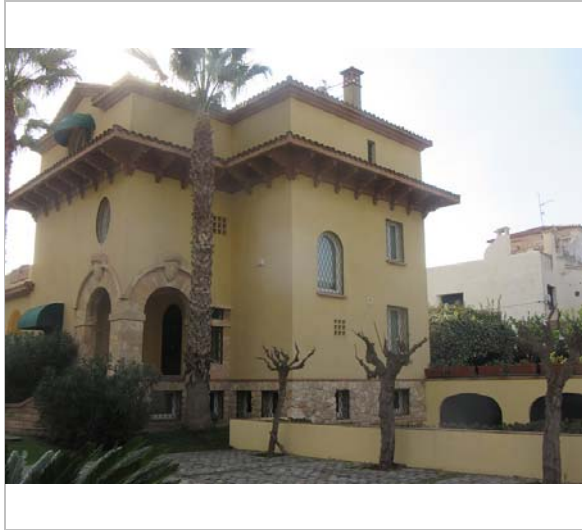
Vista de la casa. 11.12.2015. JM. Pujol
