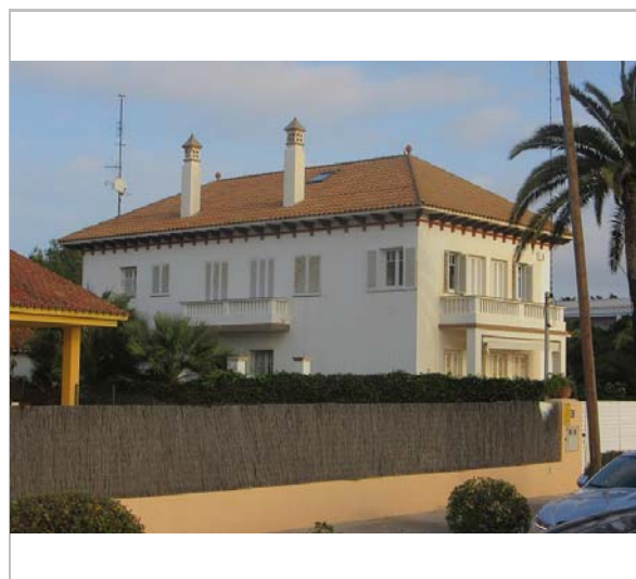
Vista de la casa. 9.12.2015. JM. Pujol
