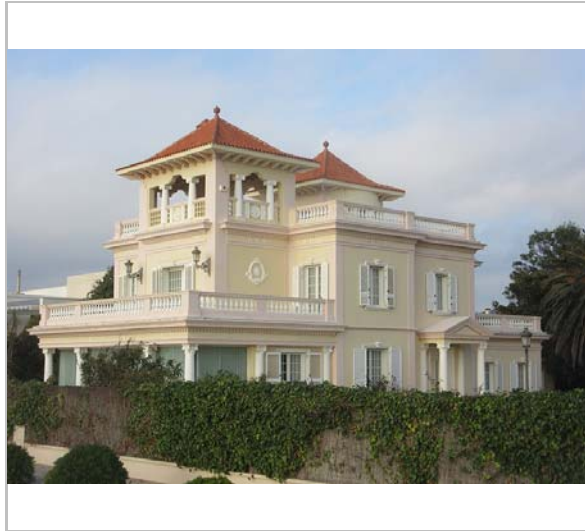
Vista de la casa. 9.12.2015. JM. Pujol
