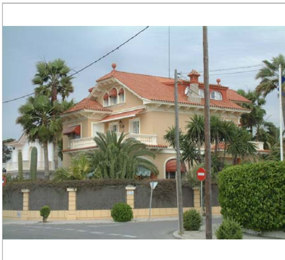
Vista de la casa. 2006. Diputació de Barcelona
