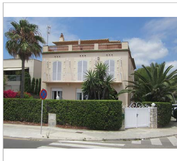
Vista de la casa. 3.7.2016. JM. Pujol
