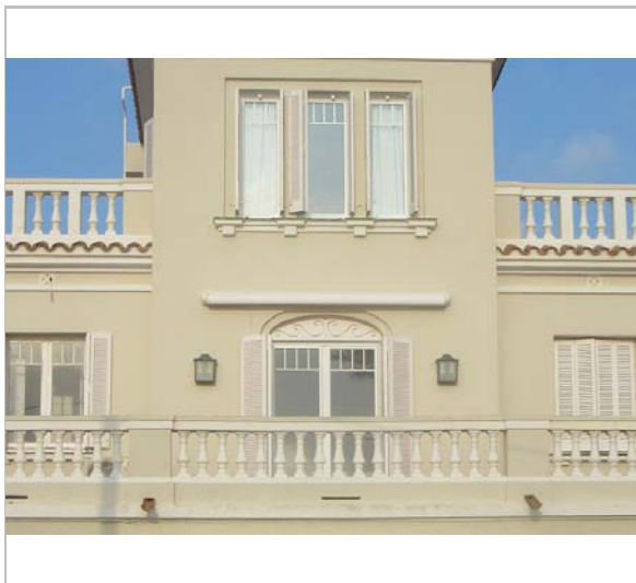
Detall de la façana. 9.12.2015. JM. Pujol
