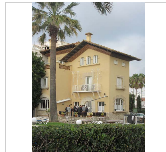
Vista de la casa. 9.12.2015. JM. Pujol
