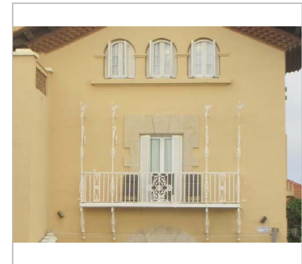
Detall de la façana. 9.12.2015. JM. Pujol
