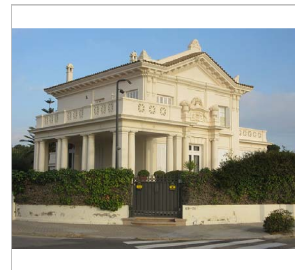
Vista de la casa. 9.12.2015. JM. Pujol
