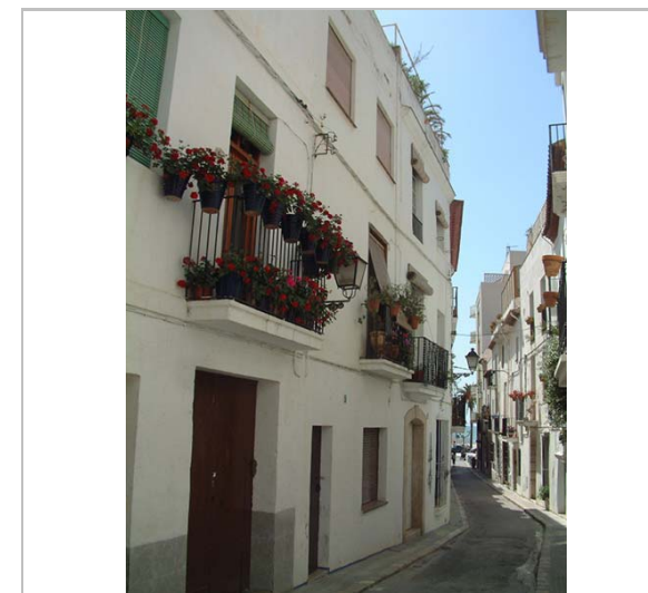
Detall de la façana. 26.4.2006 Diputació de Barcelona
