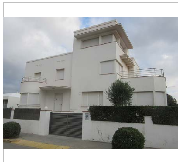
Vista de la casa. 9.12.2015. JM. Pujol
