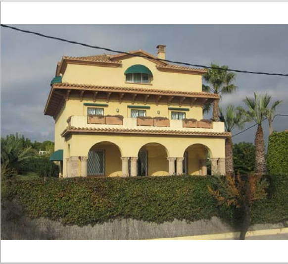
Vista de la casa. 11.12.2015. JM. Pujol
