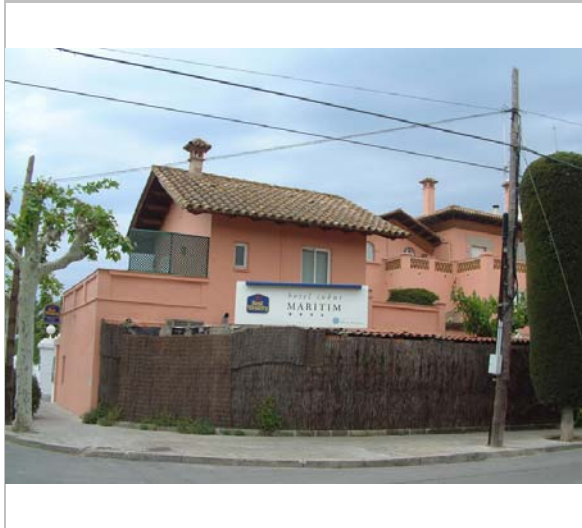
Vista de la casa. 2006. Diputació de Barcelona
