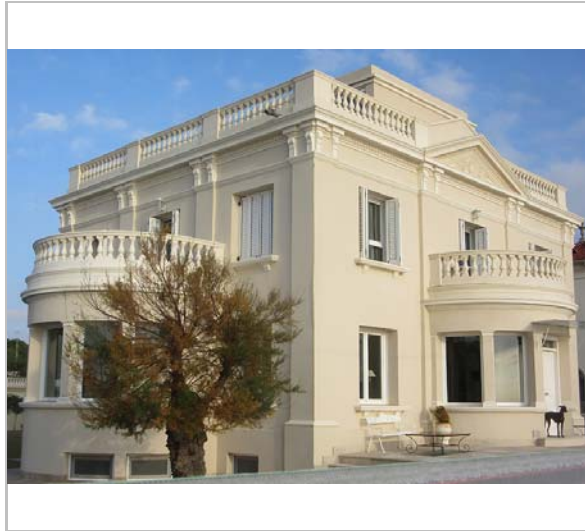
Vista de la casa. 9.12.2015. JM. Pujol
