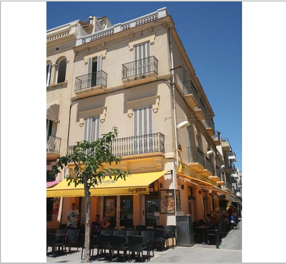
Vista de l'edifici. 23.6.2016. Sixto Pujol
