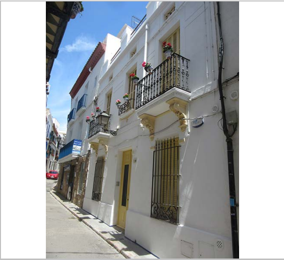
Façana. 9.6.2016. JM. Pujol
