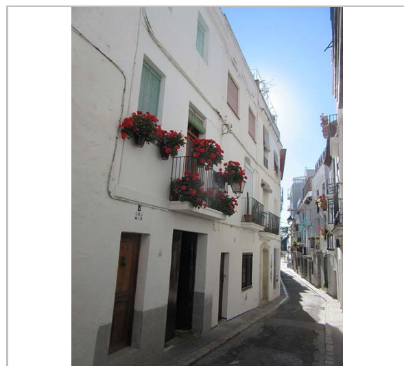
Façana. 17.11.2015. JM. Pujol
