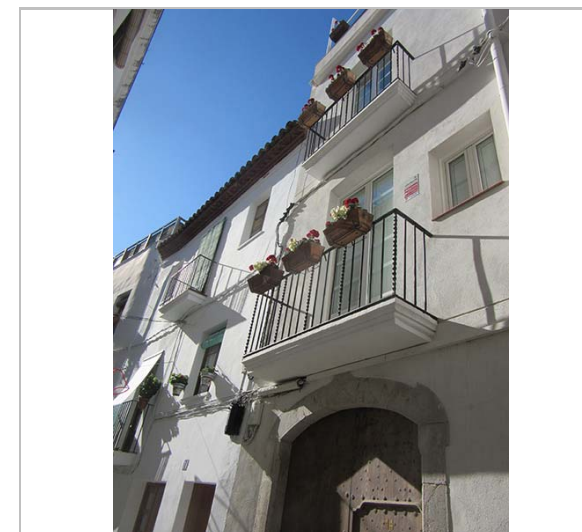
Part superior de la façana. 17.11.2015. JM. Pujol
