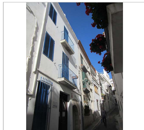
Façana. 17.11.2015. JM. Pujol
