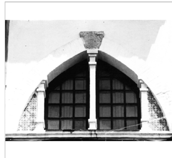
Detall de la façana. 1.5.1987 MA. Monte. IPAC.
