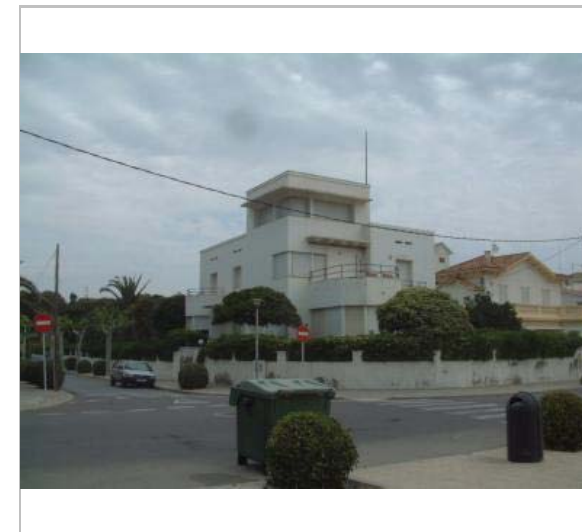
Vista de la casa. 2006. Diputació de Barcelona
