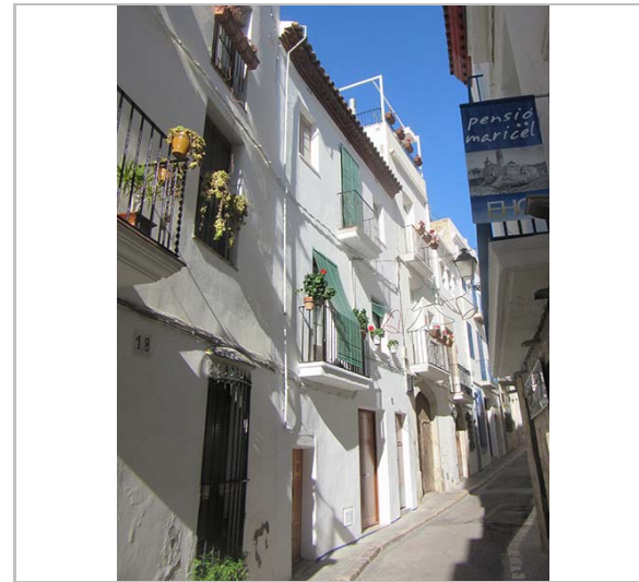
Façana. 17.11.2015. JM. Pujol
