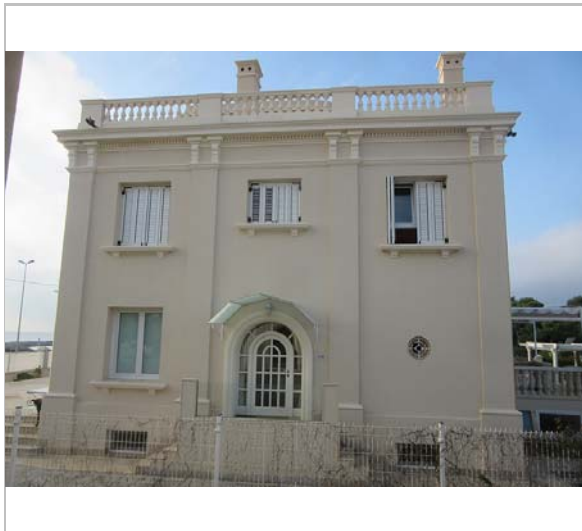
Façana lateral. 9.12.2015. JM. Pujol
