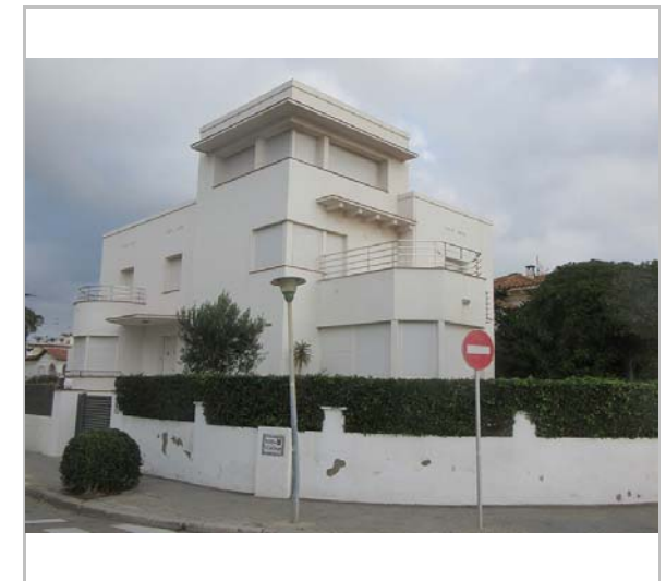
Vista de la casa. 9.12.2015. JM. Pujol
