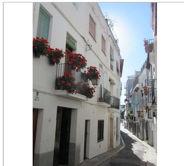
Façana. 17.11.2015 JM. Pujol
