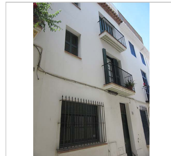
Façana. 9.6.2016. JM. Pujol
