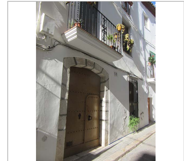
Detall del portal i el balcó. 17.11.2015. JM. Pujol
