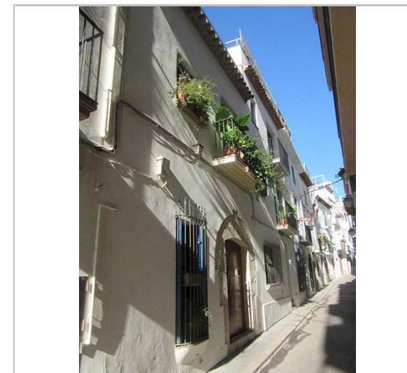
Façana. 17.11.2015. JM. Pujol
