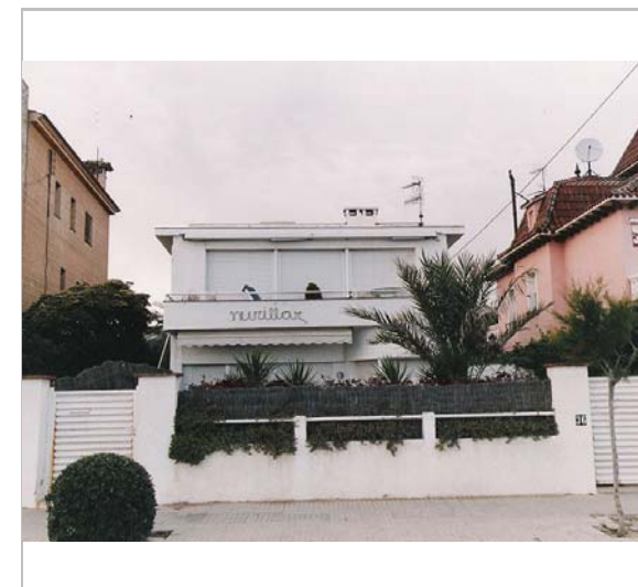
Vista de la construcció original. Criticart
