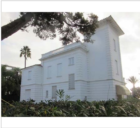
Vista de la casa. 9.12.2015. JM. Pujol
