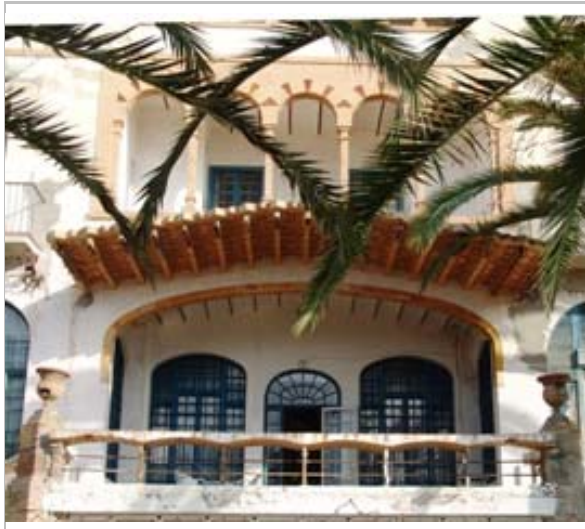
Detall de la façana principal. 2014. JM. Pujol
