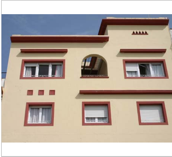
Detall de la façana. 2006. Diputació de Barcelona
