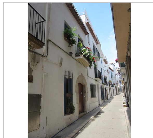
Façana. 9.6.2016 JM. Pujol
