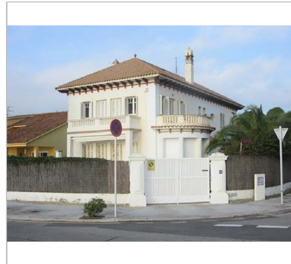
Vista de la casa. 9.12.2015. JM. Pujol
