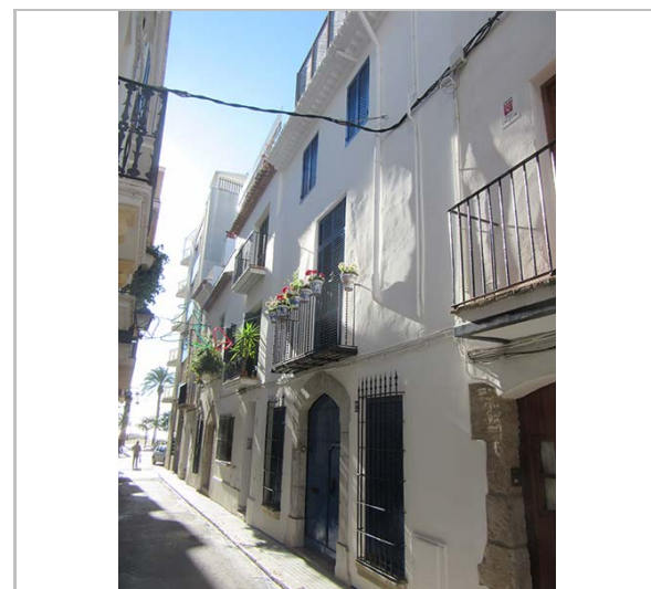
Façana. 17.11.2015. JM. Pujol
