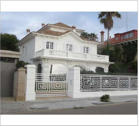
Vista de la casa. 9.12.2015. JM. Pujol
