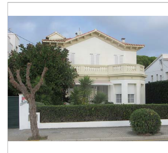
Vista de la casa. 9.12.2015. JM. Pujol
