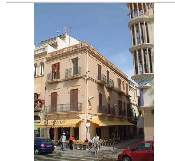
Vista de l'edifici. 3.5.2005. Diputació de Barcelona
