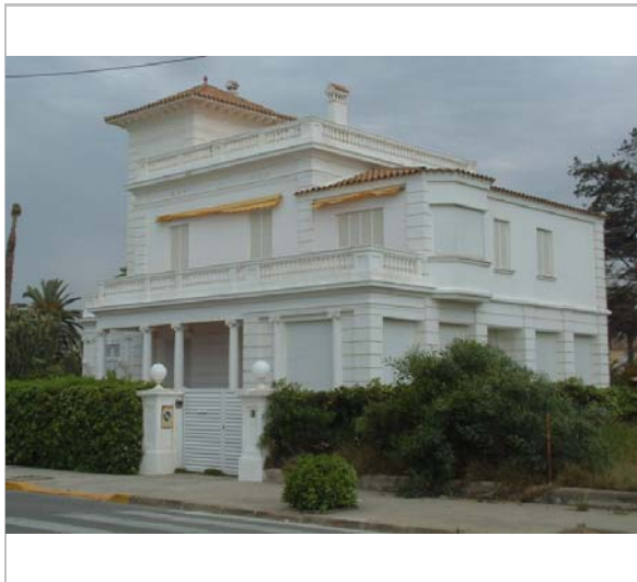
Vista de la casa. 2006. Diputació de Barcelona
