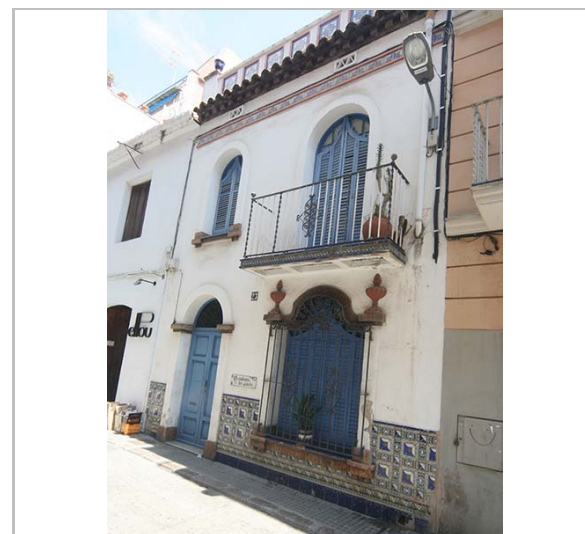
Façana. 3.6.2016. JM. Pujol
