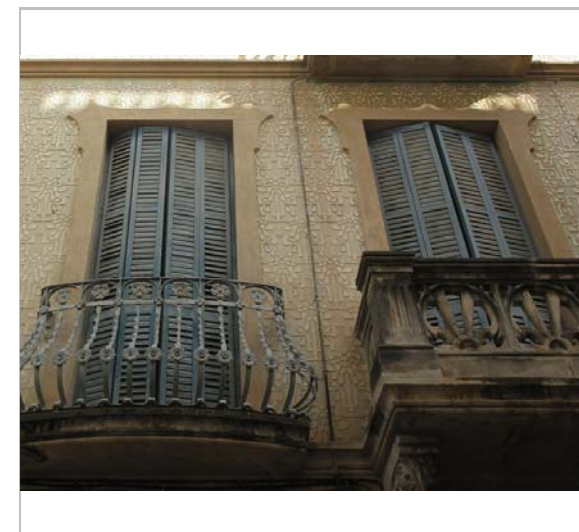
Detall de la façana. 18.1.2016. JM. Pujol
