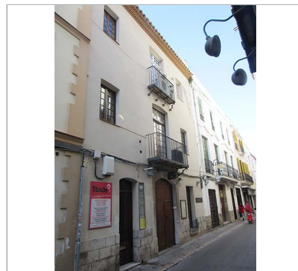
Façana. 18.1.2016. JM. Pujol
