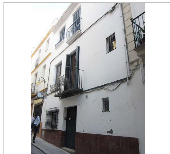
Façana. 28.19.2015. JM. Pujol
