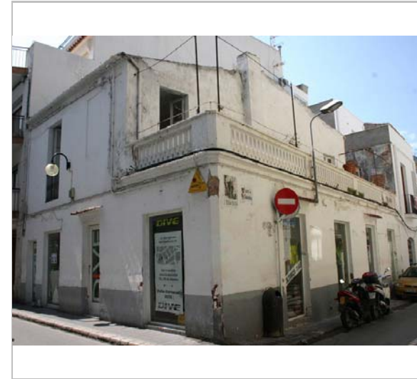
Vista de l'edifici. 2.5.2006. Diputació de Barcelona
