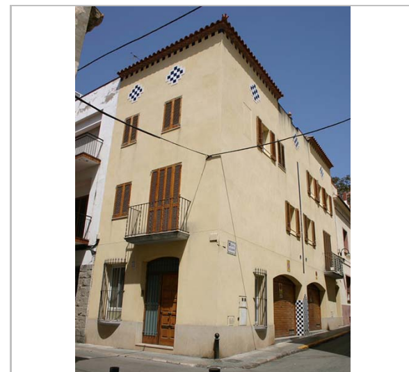
Vista de l'edifici. 2006. Diputació de Barcelona
