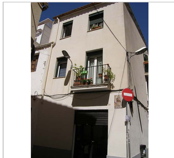
Vista de l'edifici. 22.6.2016. Foix Marsé
