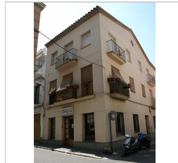
Vista de l'edifici. 2.5.2006. Diputació de Barcelona
