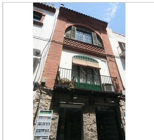
Façana. 3.6.2016. JM. Pujol
