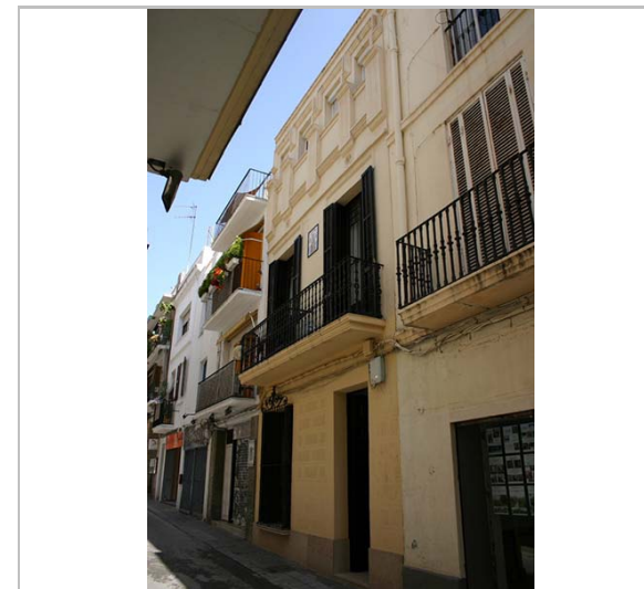
Vista de la façana. 25.4.2006 Diputació de Barcelona
