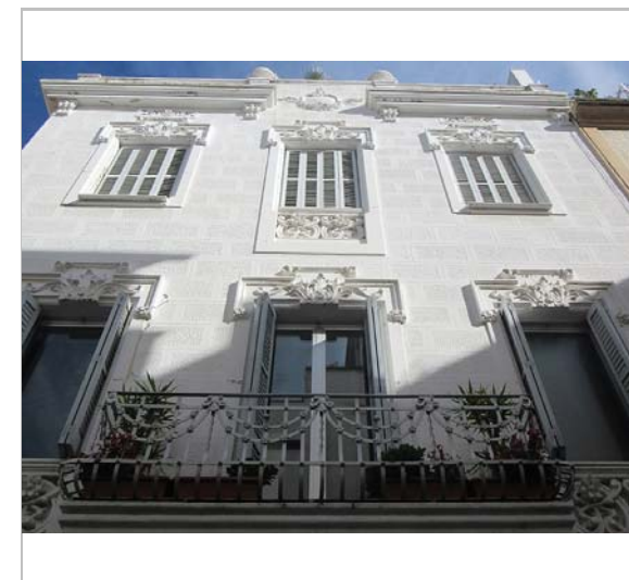
Detall de la façana. 18.1.2016. JM. Pujol
