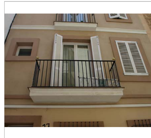
Detall de la façana. 2006. Diputació de Barcelona
