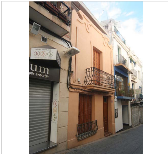
Façana. 16.6.2016. JM. Pujol
