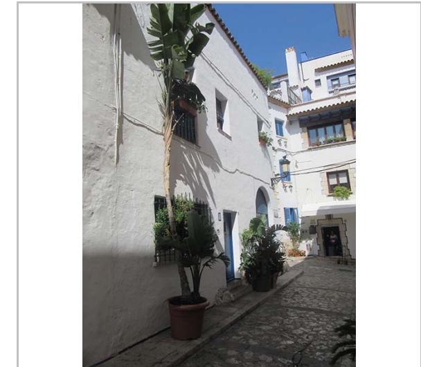
Façana del carrer de Sant Joan. 2013.
