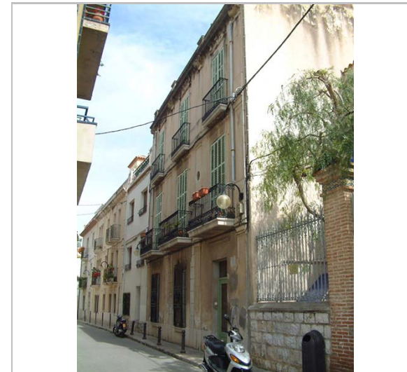
Vista de la façana. 24.4.2006. Diputació de Barcelona
