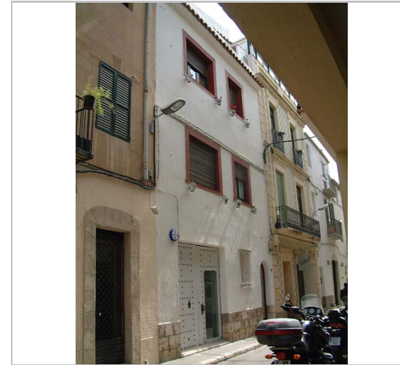
Vista de la façana. 24.4.2006. Diputació de Barcelona
