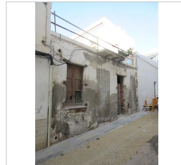
La casa a mig enderrocar. 21.10.2015 JM. Pujol
