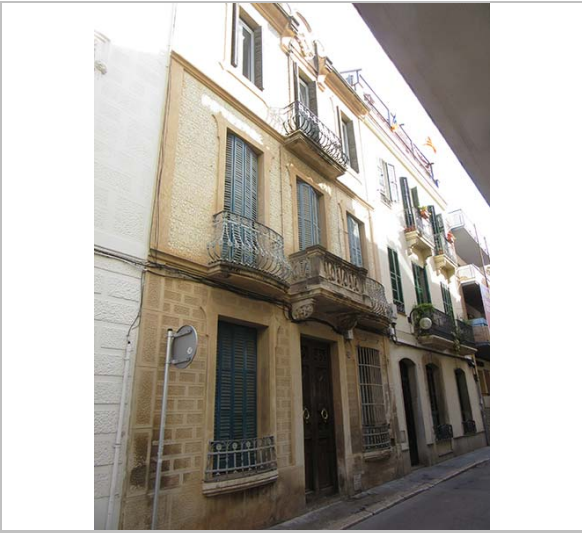
Façana. 18.1.2016. JM. Pujol
