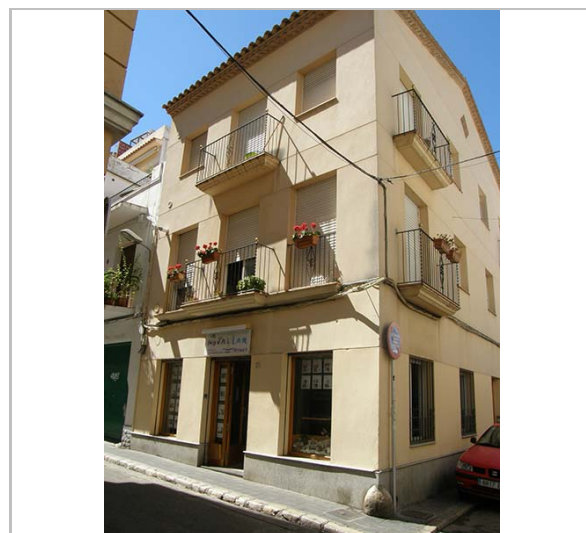
Vista de l'edifici. 22.6.2016. Foix Marsé
