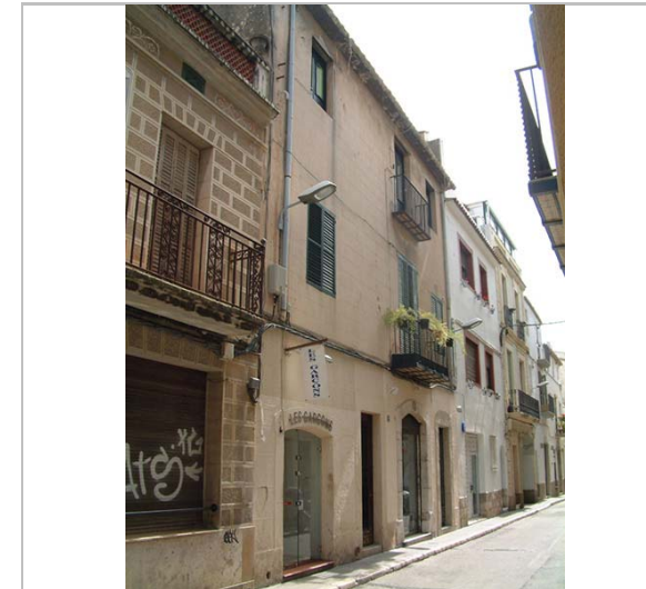
Vista de la façana. 2006. Diputació de Barcelona
