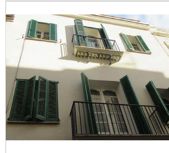
Detall de la façana. 18.1.2016. JM. Pujol
