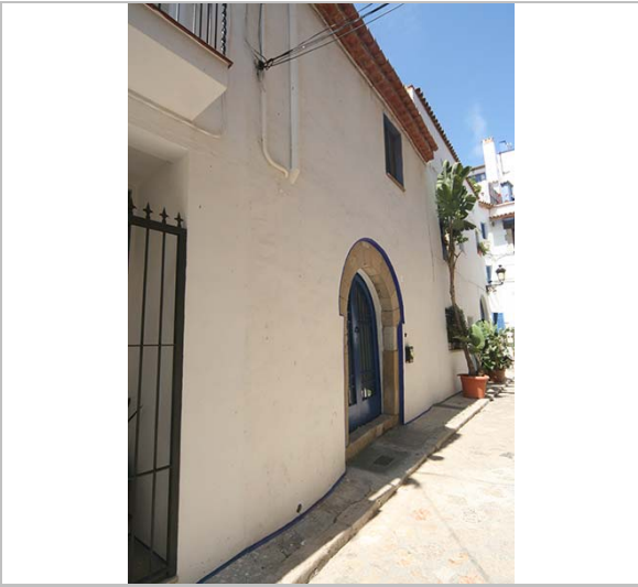
Façana. 3.6.2016. JM. Pujol
