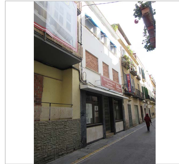
Façana del núm. 20. 18.1.2016. JM. Pujol
