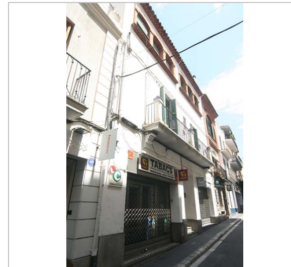
Vista de la façana. 3.6.2016. JM. Pujol
