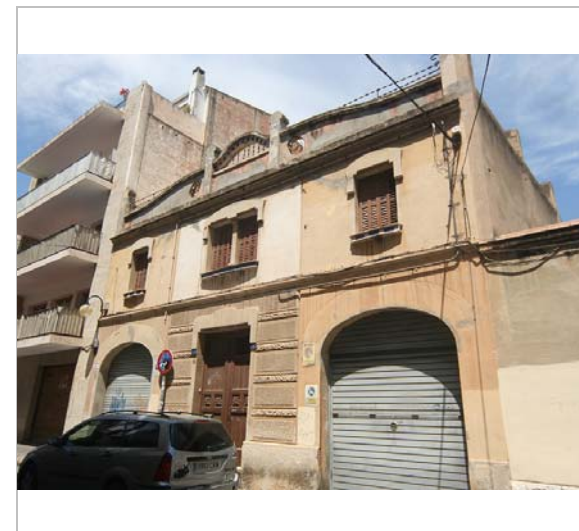
Façana. 3.6.2016. JM. Pujol
