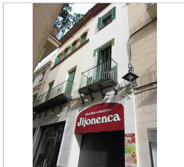
Façana. 29.2.2016 JM. Pujol
