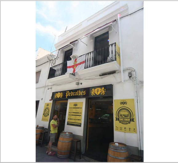
Façana. 3.6.2016. JM. Pujol
