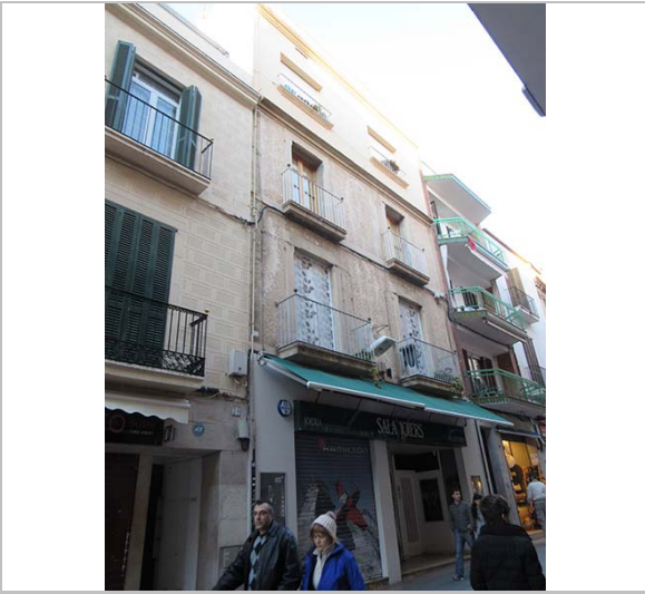
Façana. 22.2.2015. JM. Pujol
