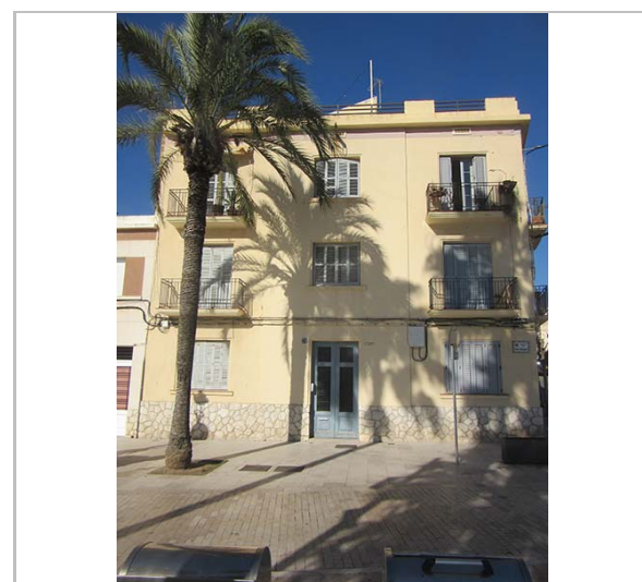
Façana. 17.11.2015. JM. Pujol
