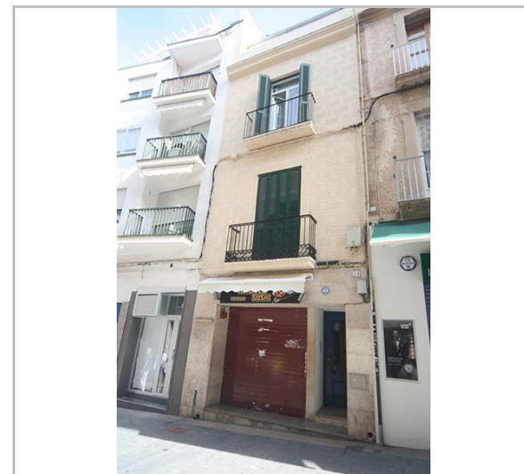
Façana. 16.6.2016. JM. Pujol
