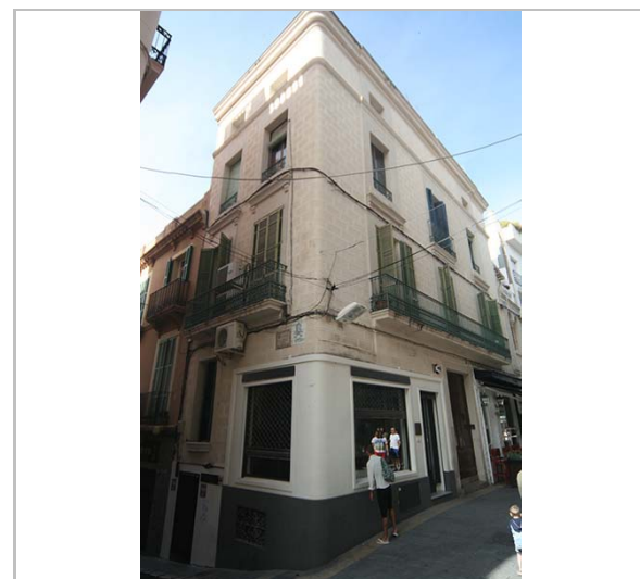
Façana. 16.6.2016. JM. Pujol
