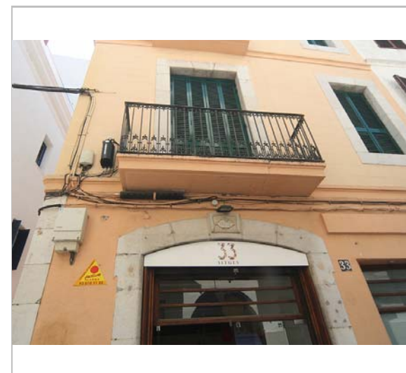
Detall de la façana. 3.6.2016. JM. Pujol
