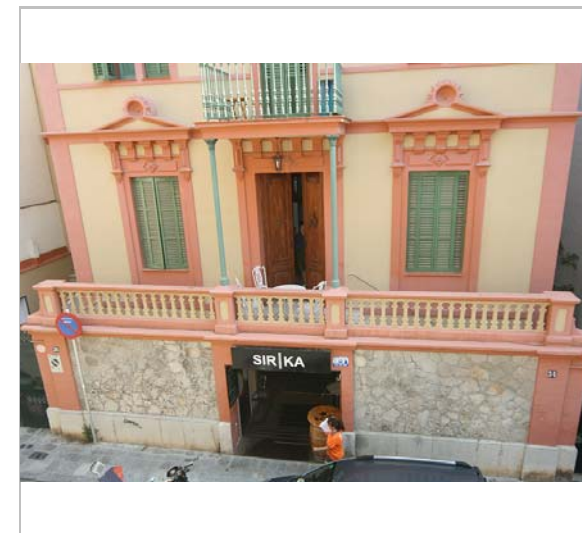
Detall de la façana. 5.8.2014. JM. Pujol
