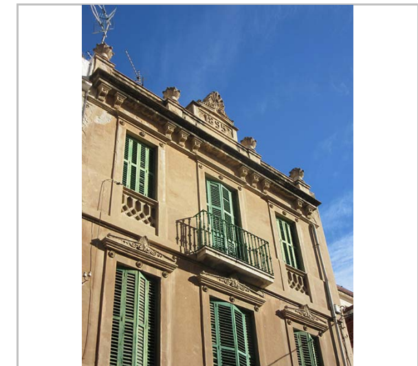
Detall de la façana. 18.1.2016. Ajuntament de Sitges
