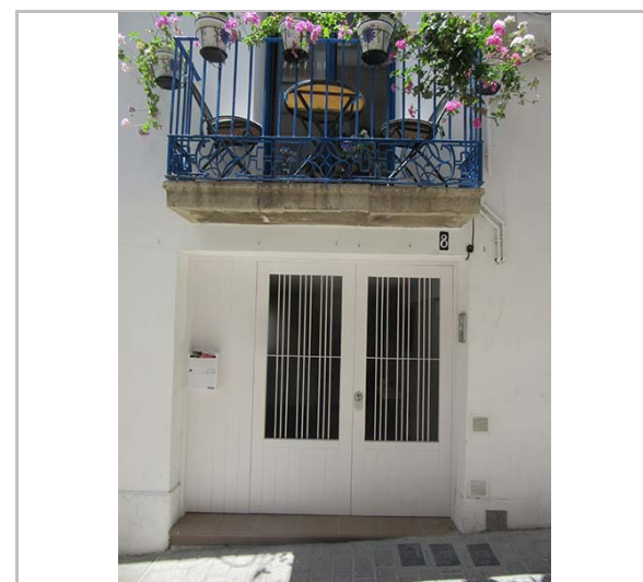
Els baixos de l'edifici. 9.6.2016. JM. Pujol
