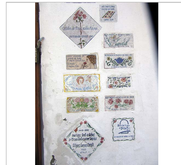
Detall de la façana. 29.7.2016.
