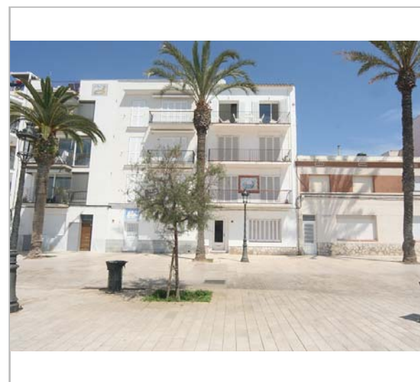
Façana. 3.3.2016. JM. Pujol
