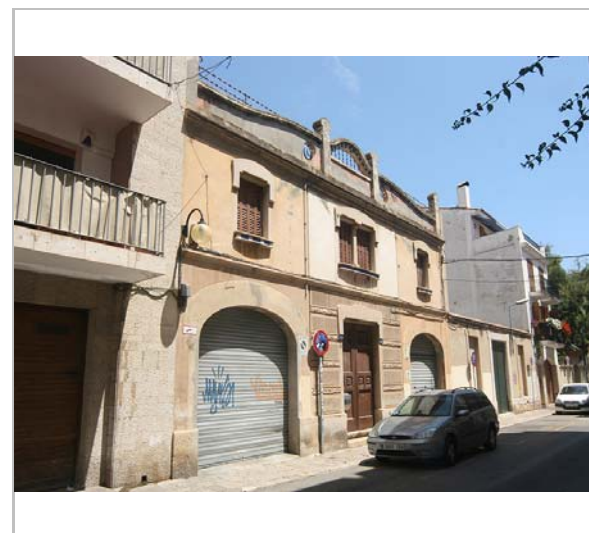
Façana. 3.6.2016. JM. Pujol
