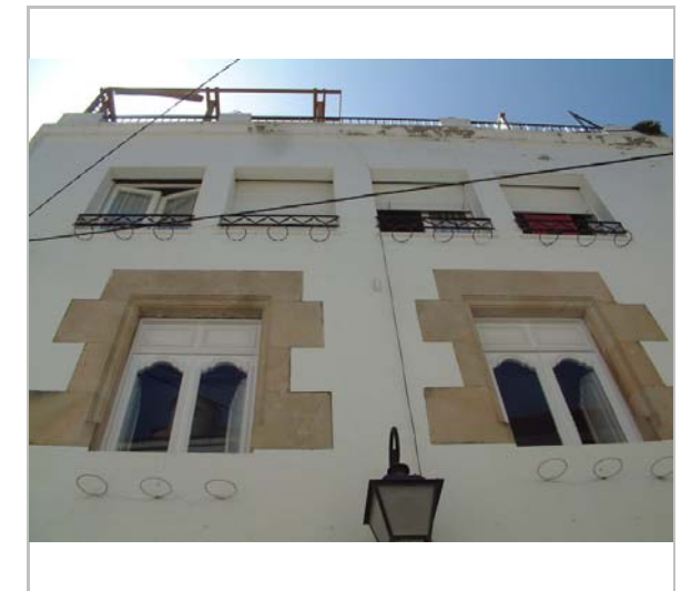
Detall de la façana. 26.4.2006. Diputació de Barcelona
