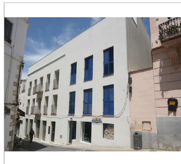
Vista de la façana. 3.6.2016. JM. Pujol
