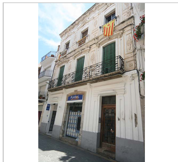
Vista de la façana. 3.6.2016. JM. Pujol
