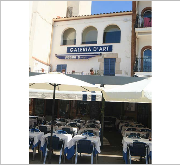
Vista de la façana. 27.6.2016. Sixto Pujol
