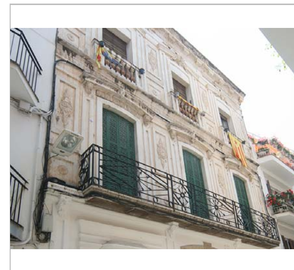
Detall de la façana. 3.6.2016. JM. Pujol
