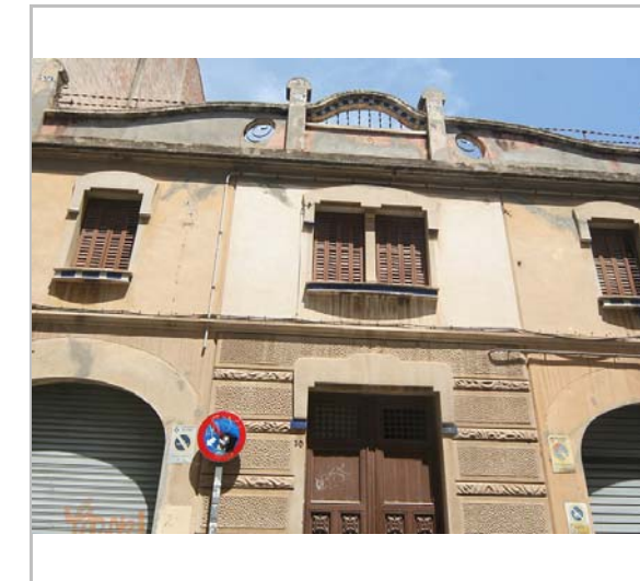
Façana. 3.6.2016. JM. Pujol
