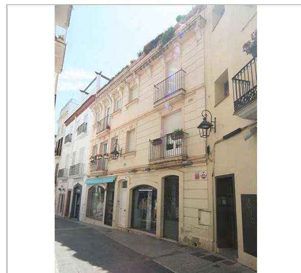
Façana. 3.6.2016. JM. Pujol
