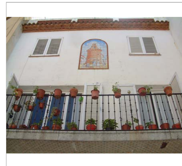
Detall de la façana. 2006. Diputació de Barcelona
