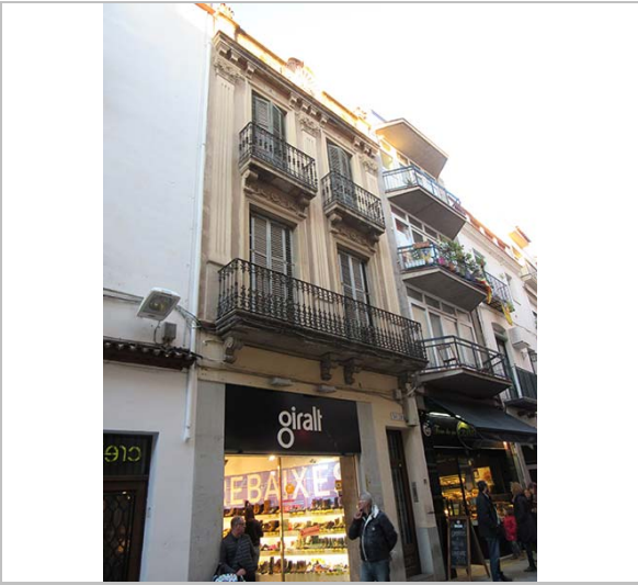
Façana. 22.2.2015. JM. Pujol
