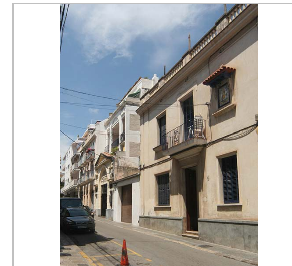
Façana del carrer de Francesc Gumà. 3.6.2016 JM. Pujol
