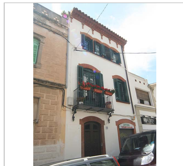
Façana. 3.6.2016. JM. Pujol
