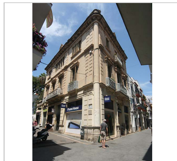
Vista de la casa. 3.6.2016. JM. Pujol
