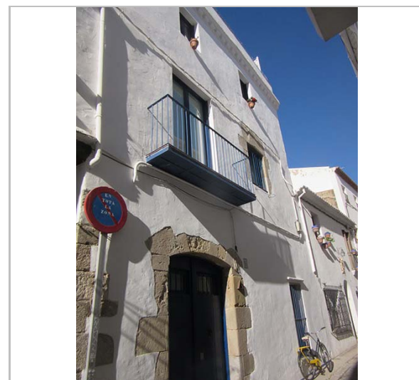
Façana. 17.11.2015 JM. Pujol
