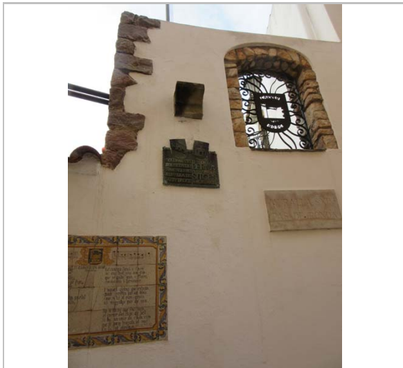
Detall de les plaques i plafons. 29.2.2016
