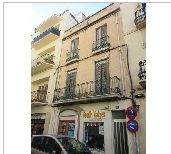
Façana. 18.1.2016. JM. Pujol
