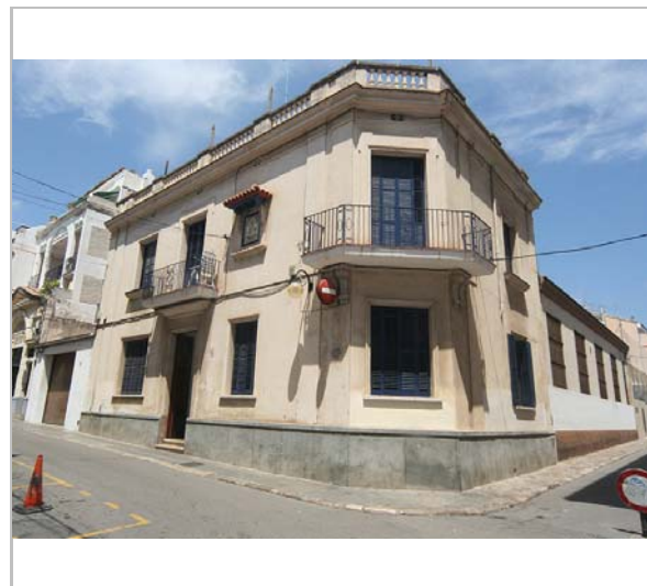
Vista de la casa. 3.6.2016. JM. Pujol
