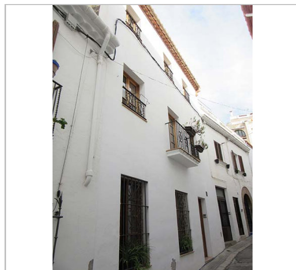
Façana. 29.2.1016 JM. Pujol
