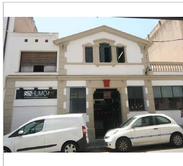
Façana. 3.6.2016. JM. Pujol
