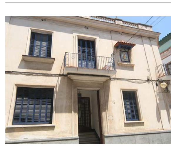
Façana. 3.6.2016. JM. Pujol
