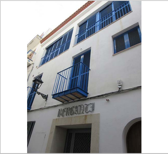
Façana. 29.2.2016 JM. Pujol
