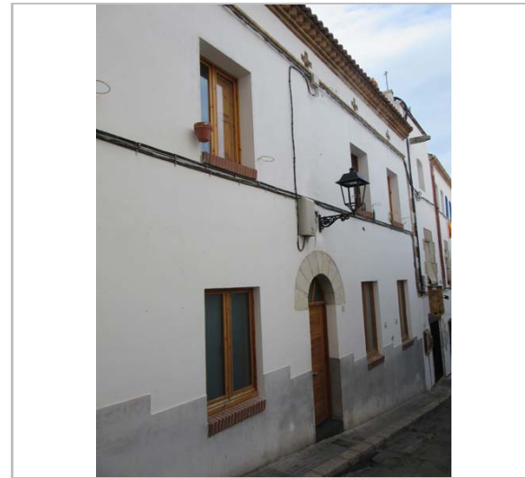
Façana. 29.2.2016 JM. Pujol
