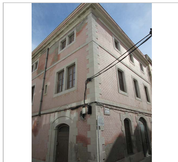
Vista de la casa. 29.12.2016. JM. Pujol
