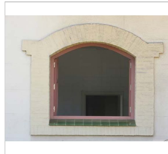
Detall de la façana. 1.7.2016. Sixto Pujol
