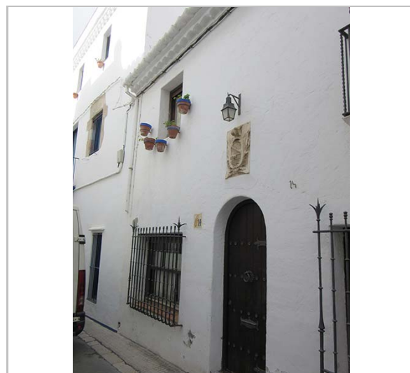
Façana. 29.2.2016. JM. Pujol
