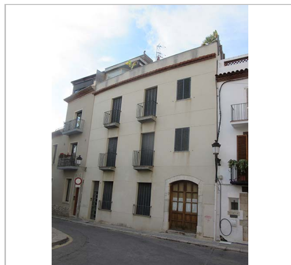
Imatge de la façana. 2.12.2015. JM. Pujol
