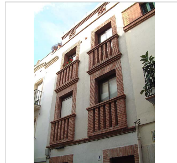
Detall dels balcons. 2006. Diputació de Barcelona
