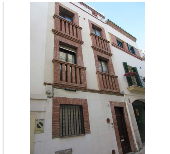
Façana. 2.1.2016. JM. Pujol
