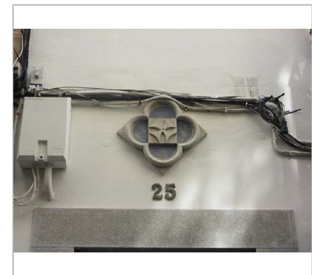
Detall de la façana. 27.6.2016 Sixto Pujol
