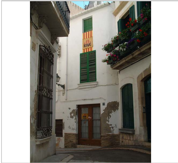
Façana principal. 19.4.2006. Diputació de Barcelona
