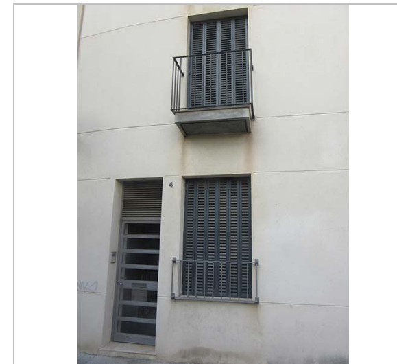
Imatge de la façana. 18.12.2015 JM. Pujol
