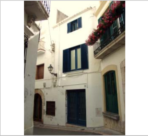
Façana principal. 18.6.2012. Ajuntament de Sitges
