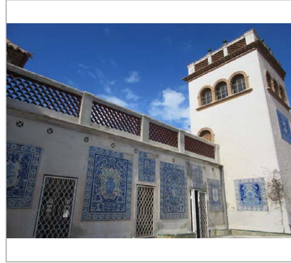
Foto del terrat i la torratxa. 2015. JM. Pujol
