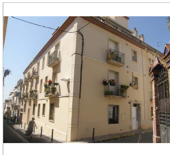
Imatge de l'edifici. 27.6.2016. Foix Marsé
