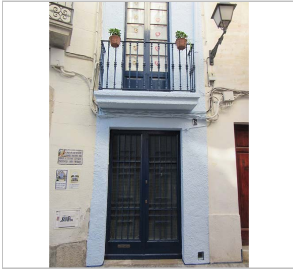
Detall de la façana. 2.1.2016.
