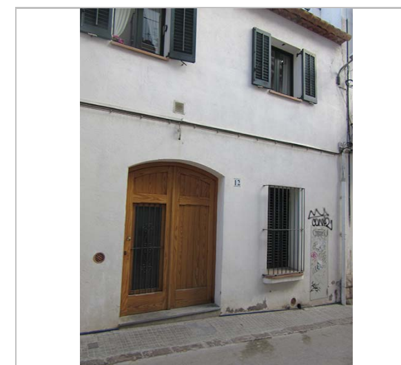
Façana del núm 12. 2.1.2016 JM. Pujol
