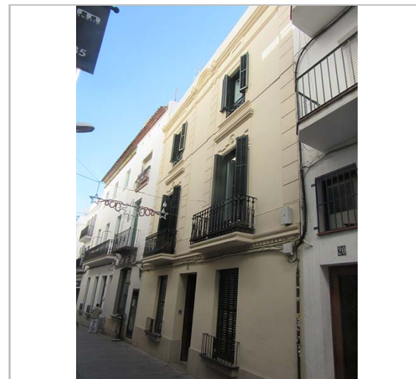
Façana. 17.11.2015. JM. Pujol
