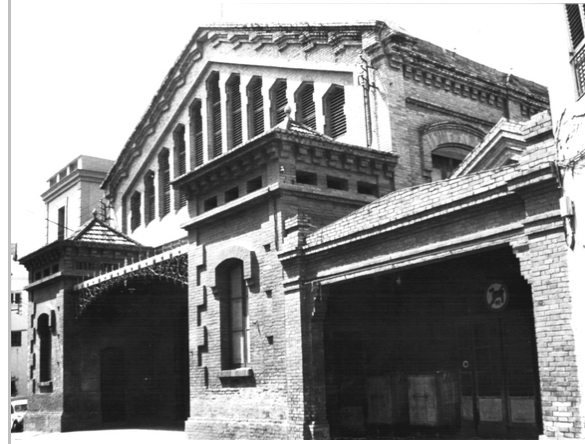
Vista de l'edifici. 1981. Isabel Coll
