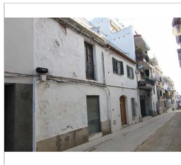
Façanes. 2.1.2016 JM. Pujol
