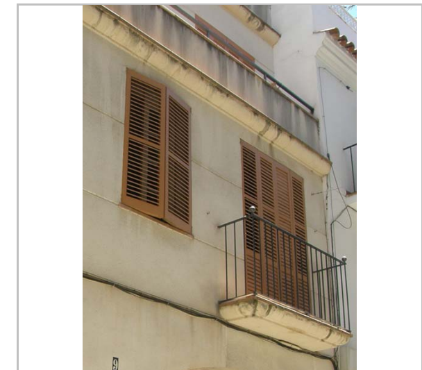
Detall de la part superior de l'edifici. 22.6.2016. Foix Marsé
