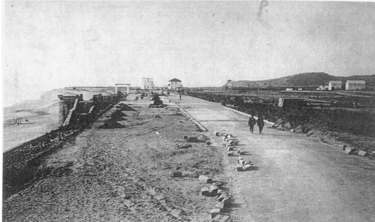
Construcció del Passeig Marítim (1922)
